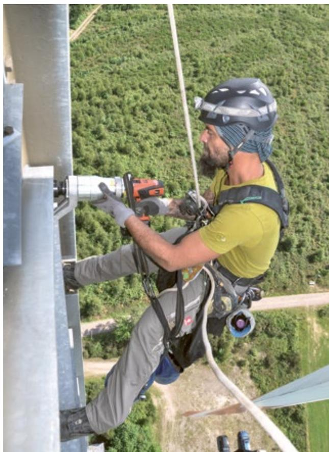
Werkzeuge für Schraubverbindungen an Windenergieanlagen sind eine Spezialität von PLARAD (Maschinenfabrik Wagner GmbH & Co. KG) aus Much im Rhein-Sieg-Kreis.
