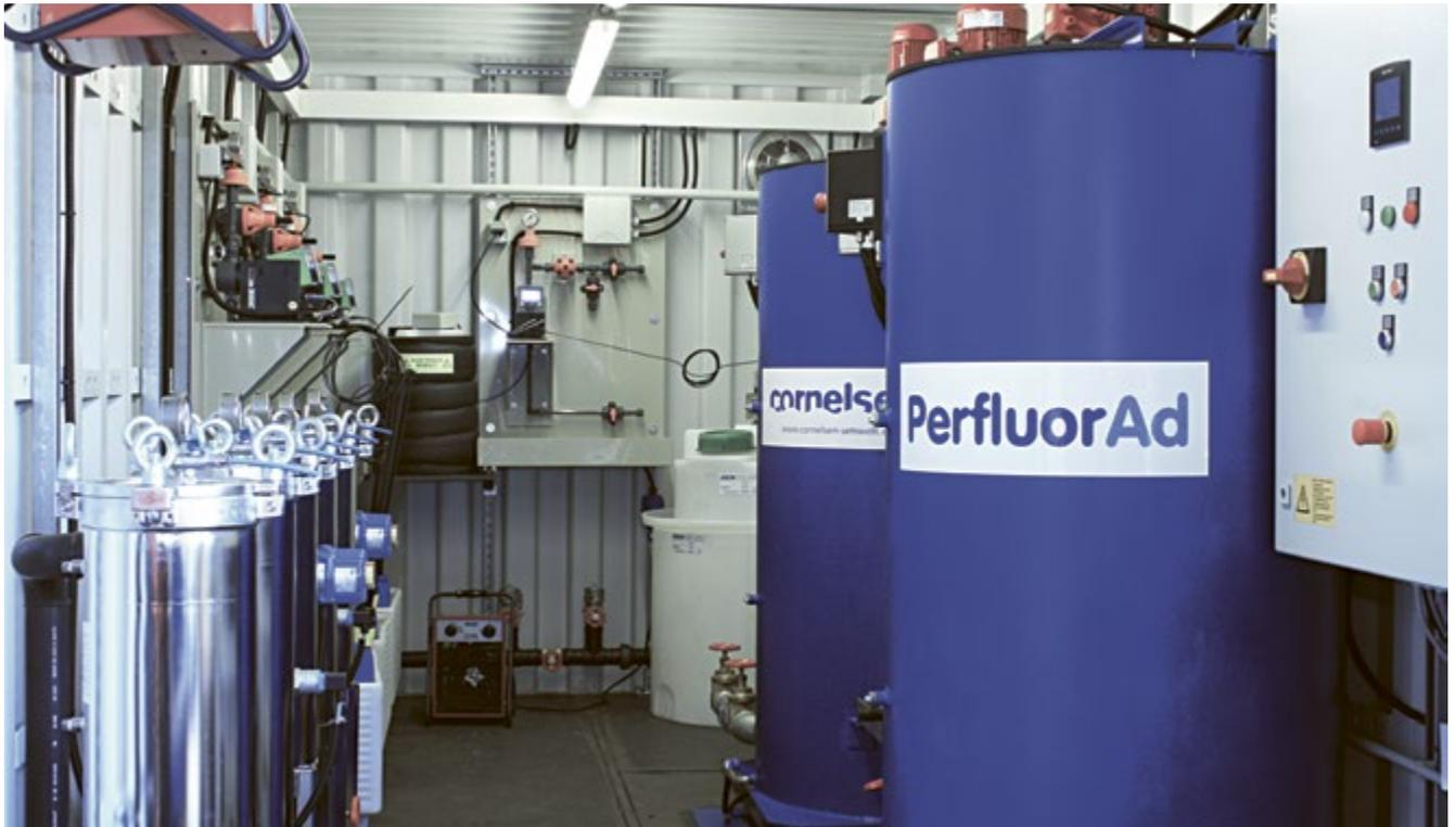
**Mobile Containeranlage zur Reinigung von PFC-belasteten Deponiesicker-, Feuerlösch- oder Grundwässern der Cornelsen Umwelttechnologie GmbH (Essen).**
