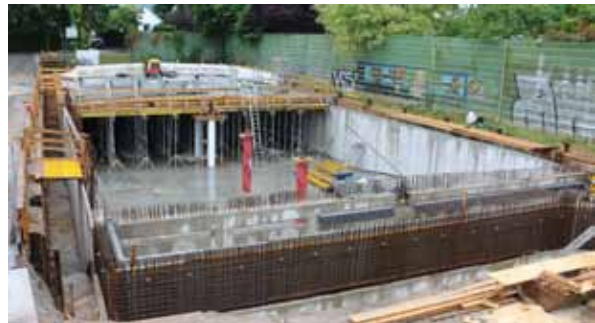
Das inzwischen fertiggestellte Regenrückhaltebecken „Im Bruchfeld“ als Baustelle im Sommer 2017. Foto: Andreas Voss
