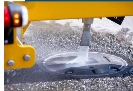
Arbeiten unter Hochspannung: Das 16-köpfige Team des Airfield-Lighting-Service des Düsseldorfer Flughafens hält die gesamte Befeuersanlage instand. Überwiegend in der Nacht, wenn der Flugverkehr ruht, tauscht das Team defekte Leuchtmittel und Feuer aus oder überprüft mit einem speziellen Messanhänger ihre Helligkeit beziehungsweise Lichtintensität.
