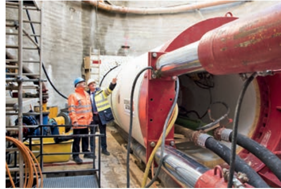
Der Bohrkopf, der eingesetzt wurde, wurde von vier Motoren angetrieben. Damit erreichte das Gerät eine Vortriebsgeschwindigkeit von sechs bis zehn Metern am Tag.
