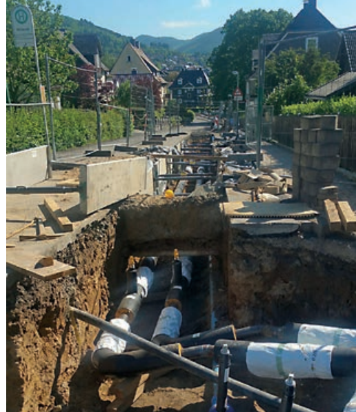
Der historische Stadtkern von Bad Laasphe rüstet auf Nahwärme um
