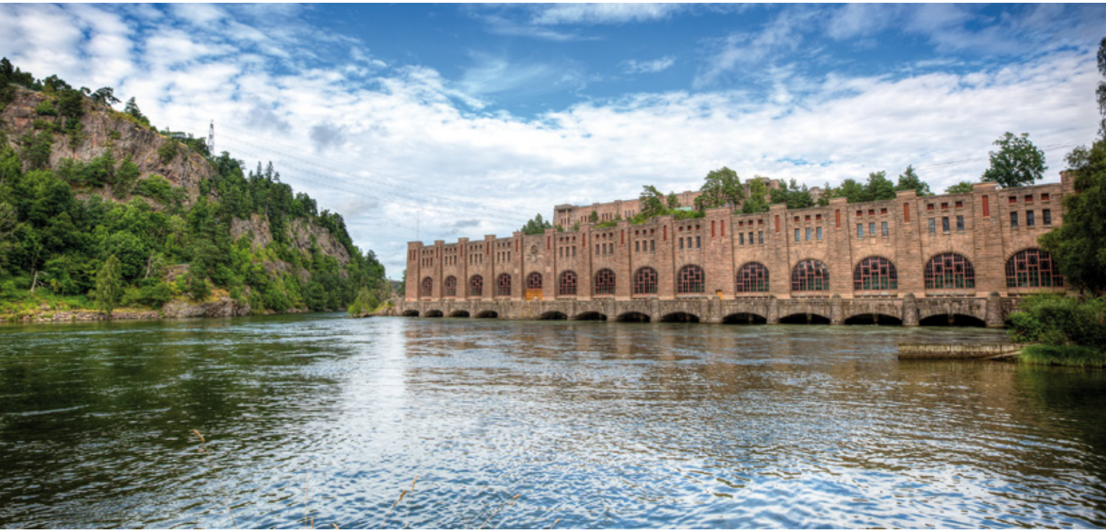
Wasserkraftwerk Olidan bei Trollhättan
