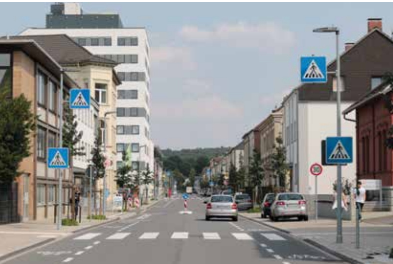
Mehr Sicherheit durch den Umbau der Möhnestraße
