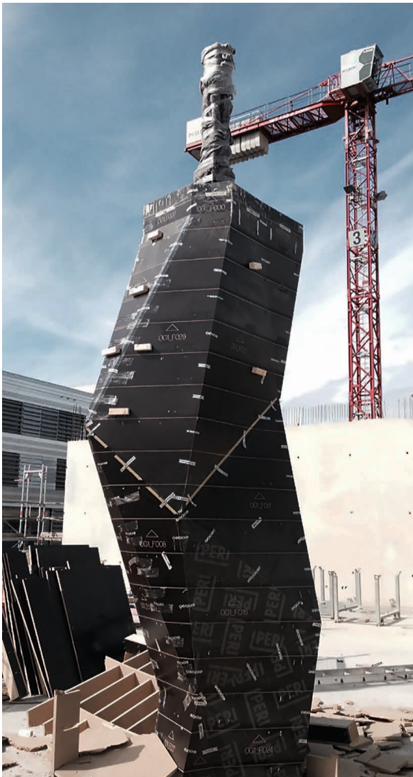
VOR ORT WURDEN DIE EINZELNEN ELEMENTE PASSGENAU AUF IHREN PLATZ GEHOBEN, MONTIERT UND DIE SÄULE BETONIERT, EHE DIE SCHALUNG NACH 3 – 5 TAGEN ENTFERNT WERDEN KONNTE
