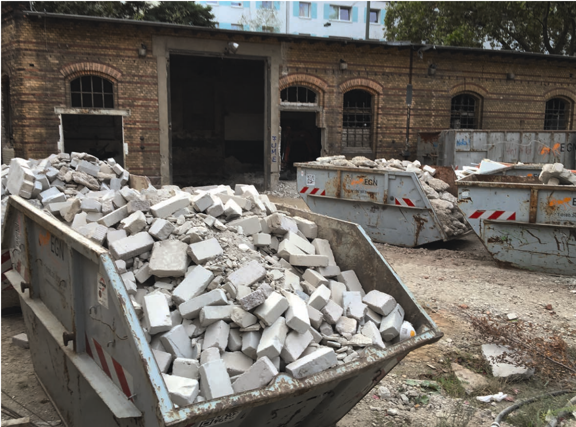
DIE PFERDEHALLE WIRD ENTKERNT
