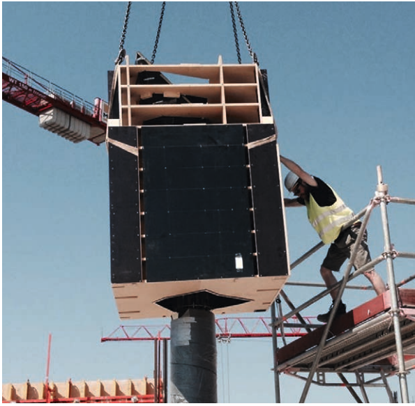
VOR ORT WURDEN DIE EINZELNEN ELEMENTE PASSGENAU AUF IHREN PLATZ GEHOBEN, MONTIERT UND DIE SÄULE BETONIERT, EHE DIE SCHALUNG NACH 3 – 5 TAGEN ENTFERNT WERDEN KONNTE
