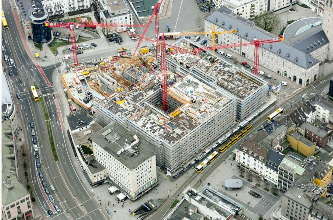
Ein Blick von oben zeigt: Mülheims großes Bauprojekt, das StadtQuartier Schlossstraße nimmt Gestalt an.
