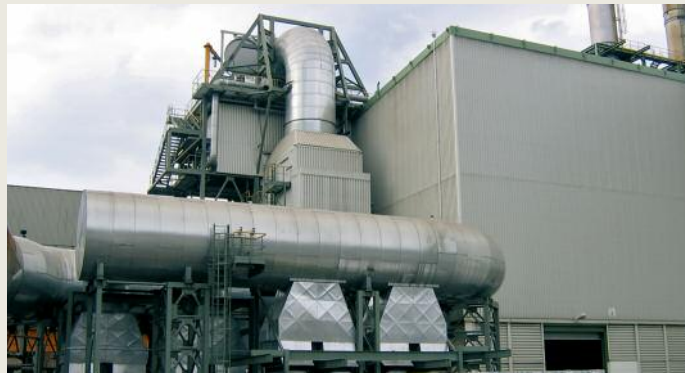
Wirtschaftlich und zukunftssicher: Das Heisskühlungsprinzip mit nachgeschalteter Wärmerückgewinnung (Bild unten). Fertig zum Einbau: Die Nachbrennkammer für eine Abgasstrecke nach einem Industrieofen.
