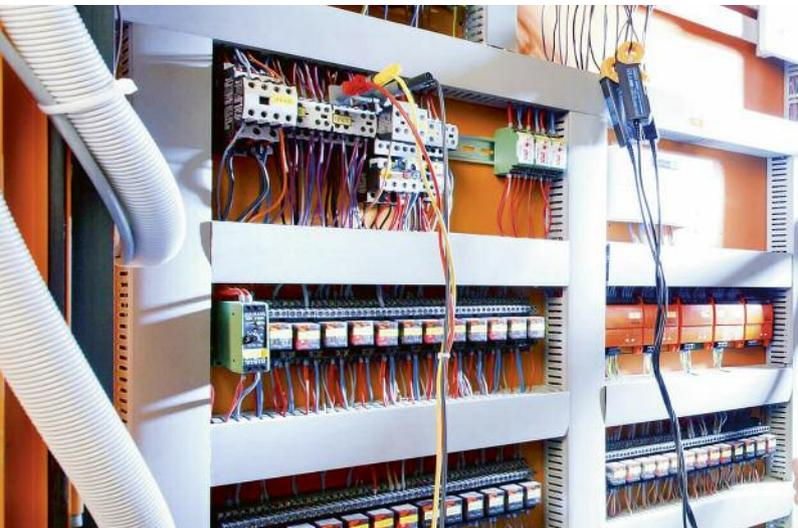
Es wird eng im Schaltschrank: Seit 18. Dezember 2017 sind Brandschutzschalter Pflicht nach DIN VDE 0100-420. Bild: TÜV NORD
