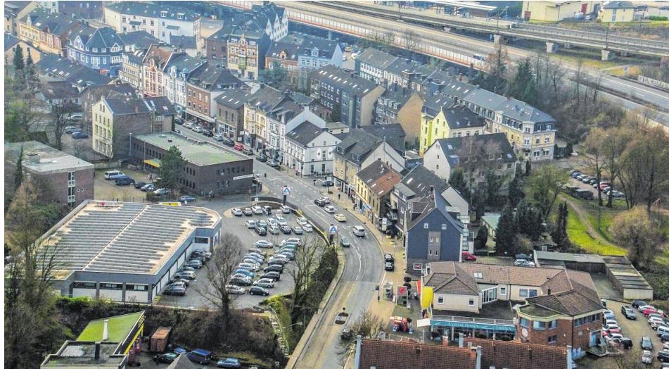
Die Kupferdreher Straße an der Ecke zur Poststraße. Wegen des Aldi-Neubaus wurde die Straße um zwei Meter verbreitert, eine Bruchsteinmauer fiel. FOTO: MICHAEL GOHL
