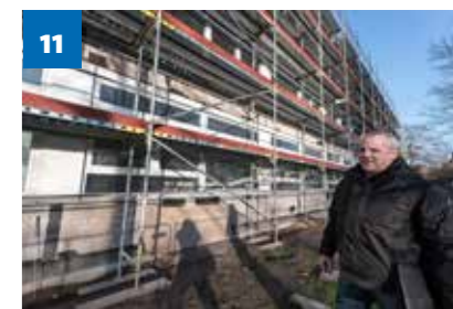
Schulsanierungen und -umbauten
