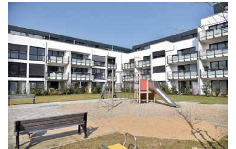
Die Neubaumaßnahme des Pilotprojekts an der Steinhausstraße mit 13 altengerechten Wohnungen
