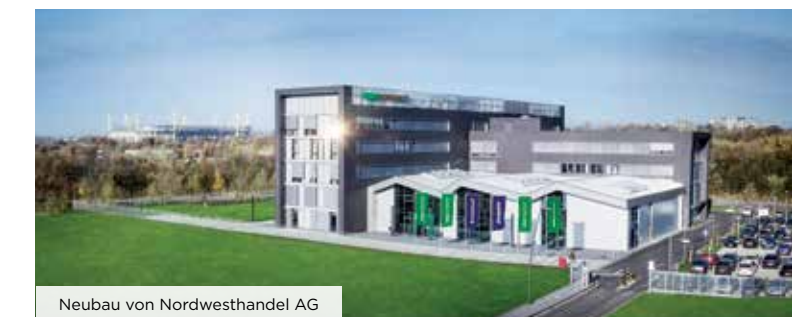
Neubau von Nordwesthandel AG
