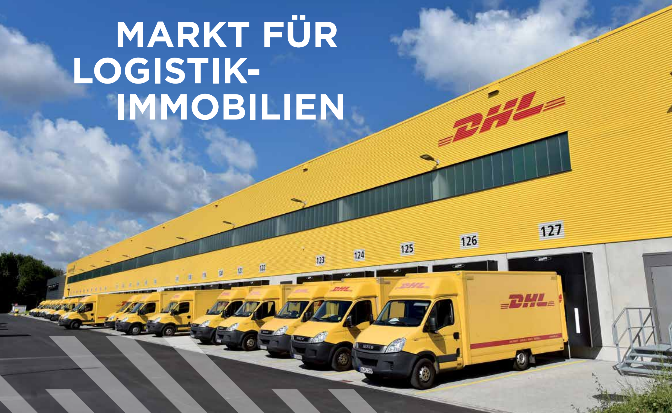
Mechanisierte Zustellbasis der DHL
