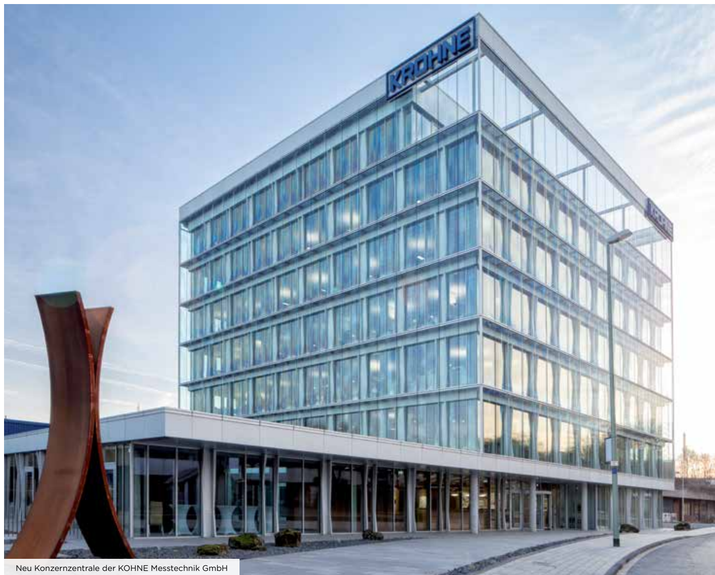
Neu Konzernzentrale der KROHNE Messtechnik GmbH
