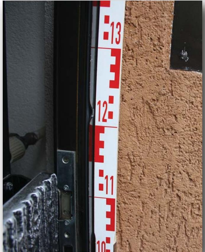
Hier sind am Türrahmen deutlich die Hebelspuren des Einbruchsversuchs zu erkennen.
