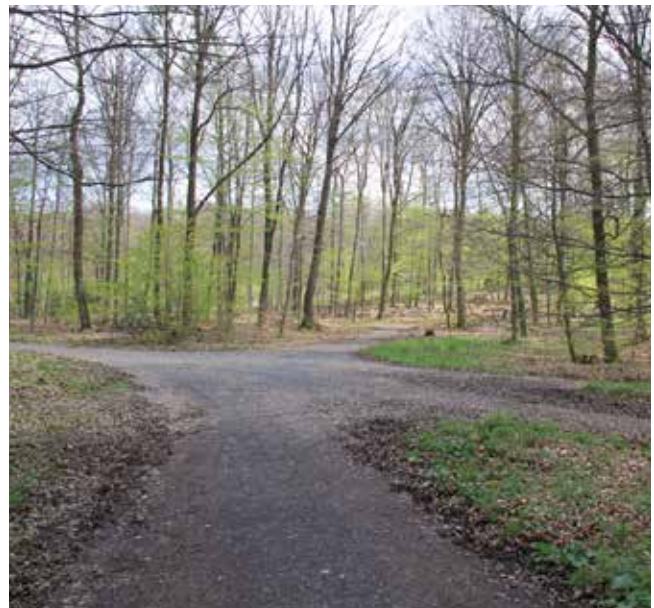
Vielfältige Ansprüche an die Waldleistungen erfordern manchmal eine hohe Infrastruktur. Sechs Waldwege münden in eine Wegekreuzung.
