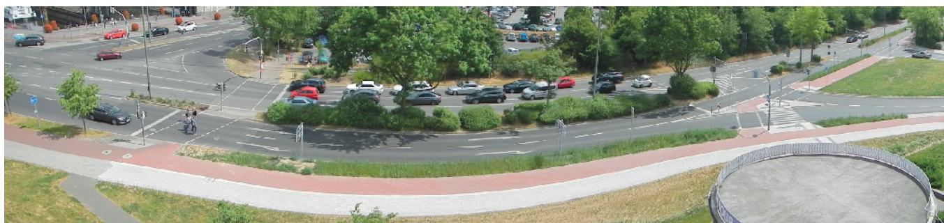
Der Lückenschluss des neuen Radwegs am Kehlturn ist fertig. In einer scharfen Links-Rechts-Kurve wird das Fahrerfeld der Tour de France von der Hammer Landstraße kommend in die Zollstraße Fahrt aufnehmen.
