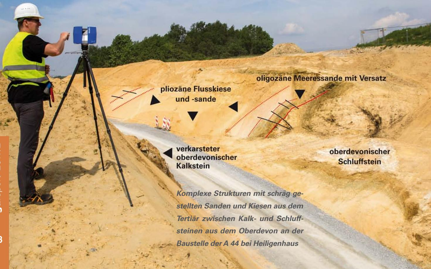
*Komplexe Strukturen mit schräg gestellten Sanden und Kiesen aus dem Tertiär zwischen Kalk- und Schluffsteinen aus dem Oberdevon an der Baustelle der A 44 bei Heiligenhaus*
