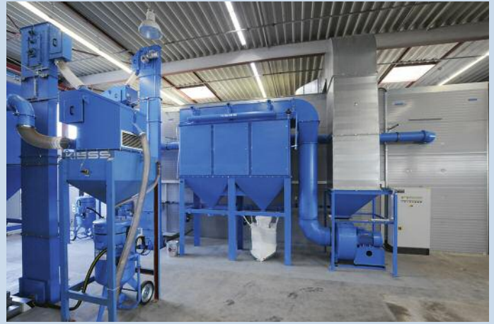
Einblick in eine Strahlhalle mit seitlicher Anlagentechnik bestehend aus Filteranlage und automatischer Strahlmittelrückförderung.
