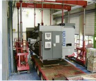
Bild links: Firmenumzug eines kompletten Werkzeugbaus mit 18 Bearbeitungszentren mittels hydraulischem Hubgerüst inklusiv Demontage, Transport, komplette Remontage, Feinjustierung. Bild rechts: Ausbringung einer 85t Presse über das Dach mit unserem Litzenhebersystem.
