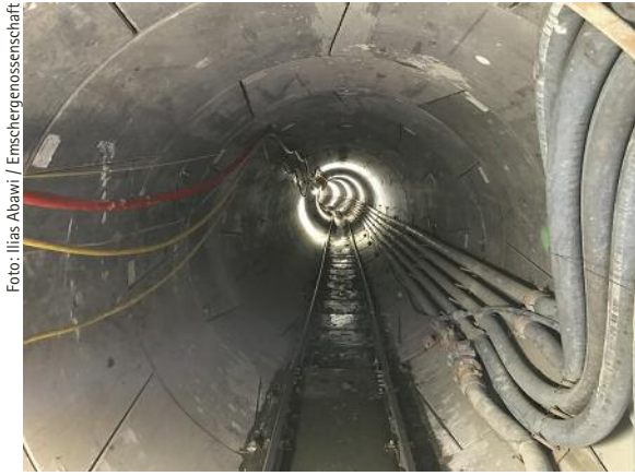
Blick in den Abwasserkanal Emscher mit seiner Ringstruktur.
