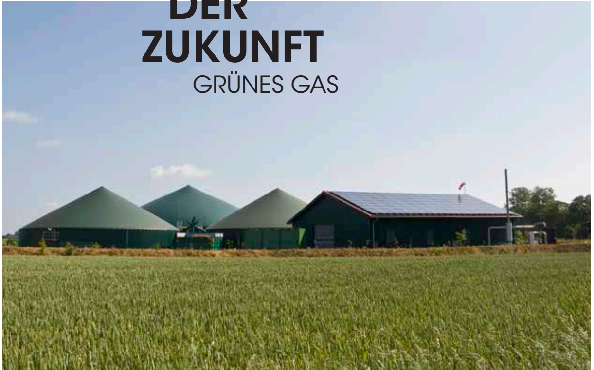
VERGÄRUNGSANLAGE AUF EINEM BAUERNHOF IN NIEDERSACHSEN
