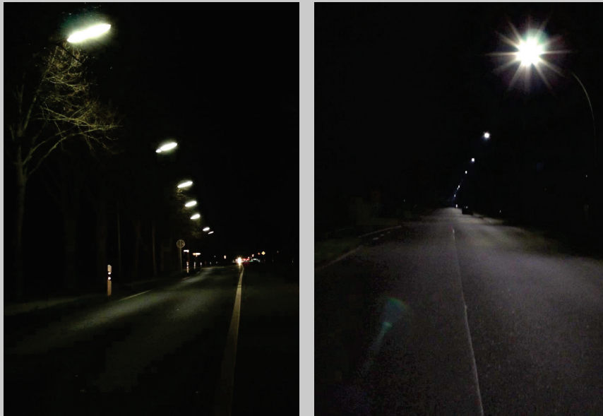
Abbildung 5: ungleichmäßige Beleuchtung vor (links) und gleichmäßige Beleuchtung mit weniger Streulicht nach (rechts) einer Sanierung 11
