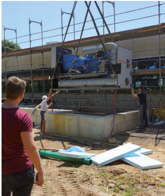
Das gut und gerne vier Tonnen schwere Blockheizkraftwerk wird über das Hallendach gehoben.
