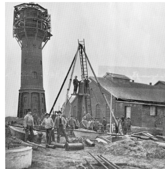
Der Bau des Wasserturms an der Nordstraße 1897-98.
