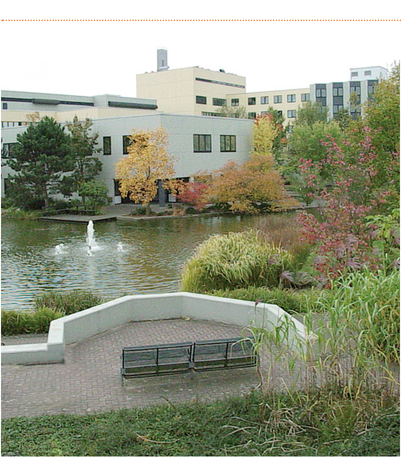
Außenansicht des Kreiskrankenhauses in Dormagen
