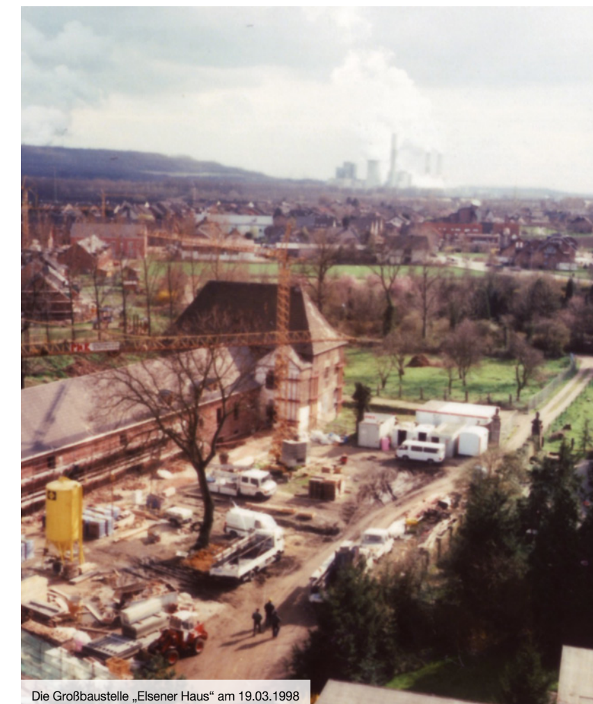
Die Großbaustelle „Elsener Haus“ am 19.03.1998
