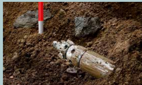
TRACTO-TECHNIK ermöglicht es, Rohre grabenlos unter Straßen hindurch zu verlegen.
