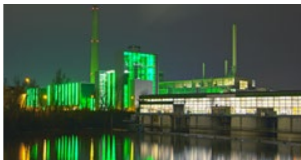
Fortuna - so heißt das neue Kraftwerk auf der Lausward.
