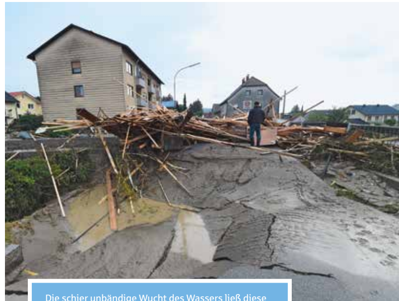
Die schier unbändige Wucht des Wassers ließ diese Asphaltstraßendecke in Simbach am Inn bersten. (Quelle: picture alliance / dpa)
