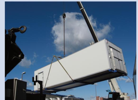
Eine Besonderheit stellt die modular konzipierte SuperBoxXL dar, die je nach Bedarf nahezu beliebig zu großflächigen Kühl- bzw. Wärmelagern kombiniert werden kann. Die Anlagen sind im Freien – auf festem Boden oder speziellen Gestellen – aufstellbar und schnell einsatzbereit. Bei Bedarf ist auch die Andockung an Gebäude, Laderampen oder Raumcontainer möglich.
