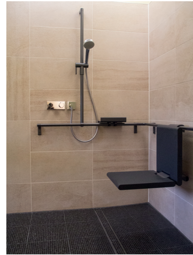
Bequem zu reinigen, rutschsicher, mit Haltegriffen und einem im Bedarfsfall klappbaren Duschhocker: Dieses Bad ist barrierefrei.
