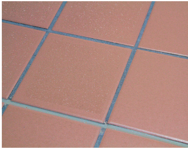
Ein rutschhemmender Antislip-Belag kann auch nachträglich auf Fliesen oder Duschtassen aufgebracht werden
