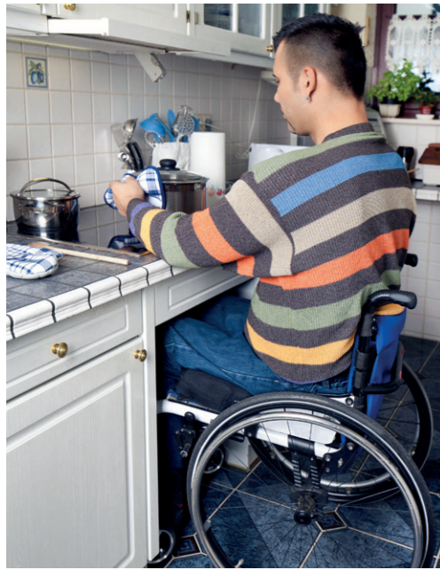
Eine niedrige, unterfahrbare Arbeitsplatte in der Küche eignet sich für Menschen im Rollstuhl ebenso wie für Menschen, denen langes Stehen in der Küche zusehends schwerfällt.
