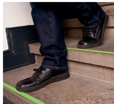
Es müssen nicht immer große Umbaumaßnahmen sein. Schon ein fluoreszierendes Band an den Treppenkanten erhöht die Sicherheit.
