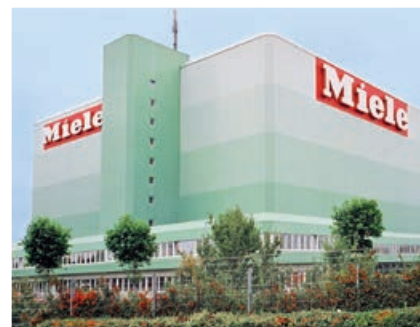
Auch Miele macht's: Der Hausgerätehersteller setzt mit seinem BHKW (Foto oben) auf Effizienz.
