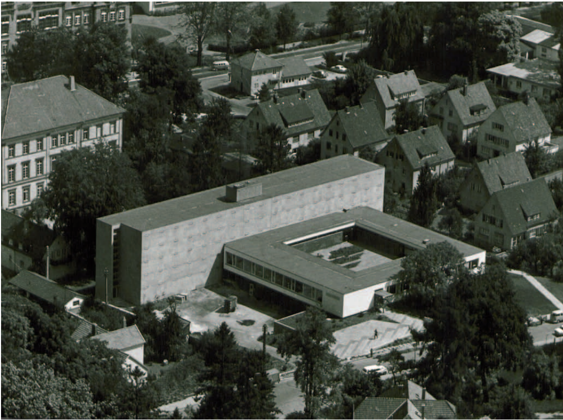
Abb. 2: Das gerade fertiggestellte Staatsarchiv Detmold aus der Luft. Deutlich zu erkennen ist der nach Süden nahezu fensterlose Magazinbau, in dem die Bestände des Personenstandsarchivs bis heute verwahrt werden. (LAV NRW OWL, D 75 Nr. 9783,8)
