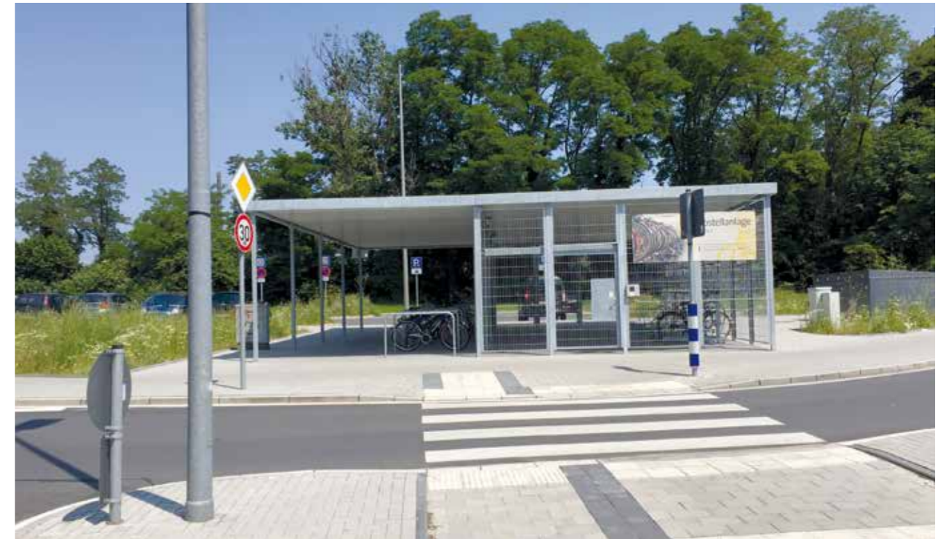
Die neue Abstellanlage am Bahnhof Oberhausen-Holteln
