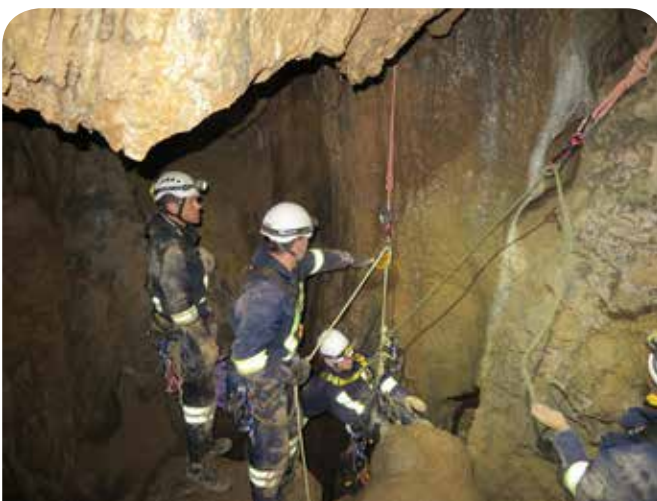
Über zahlreiche Umlenkrollen wurden die Seile geführt.
