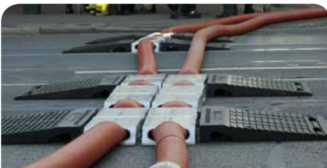
Hinweis zu obigem Bild: Der zweite Schlauch wurde nach dem ersten verlegt, es gab dann für die zweite Brücke nicht mehr genug Material. Diese Schlauchbrücken müssen verlegt werden, BEVOR der Schlauch mit Wasser gefüllt wird, nur die im nachfolgenden Bild dargestellten Brücken können auch danach noch eingebaut werden. Die sind aber nochmal größer und schwerer. (Foto: Nottebrock)
