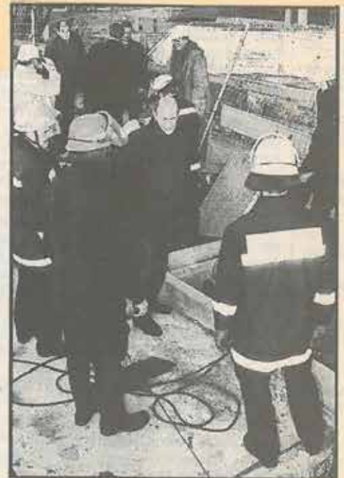
Stromausfall im Tunnel: Feuerwehrleute auf dem Dach der Röhre.
