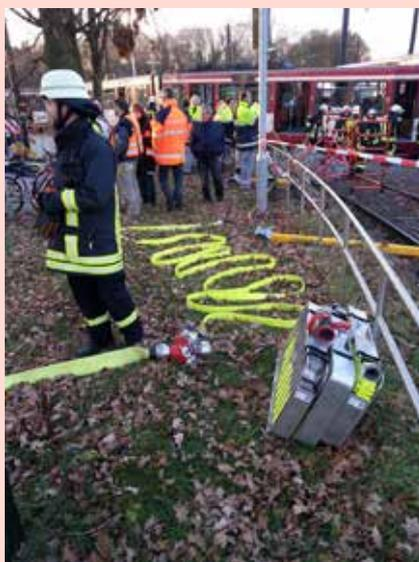
Abb. 3: Ein Teil der Brandschutzmaßnahmen, hier bereit liegendes C-Rohr.
