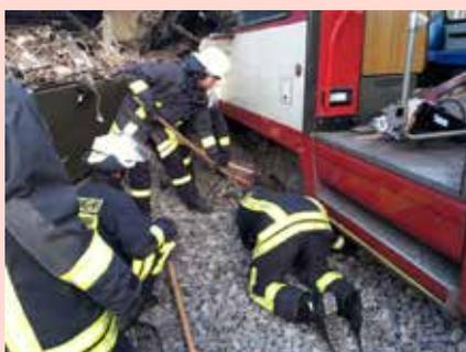
Abb. 6: Freigraben des vorderen entgleisten Drehgestells des noch z.T. im Gleisbett stehenden zweiten Bahnteils. (Foto: Umweltschutzzug Feuerwehr Düsseldorf)
