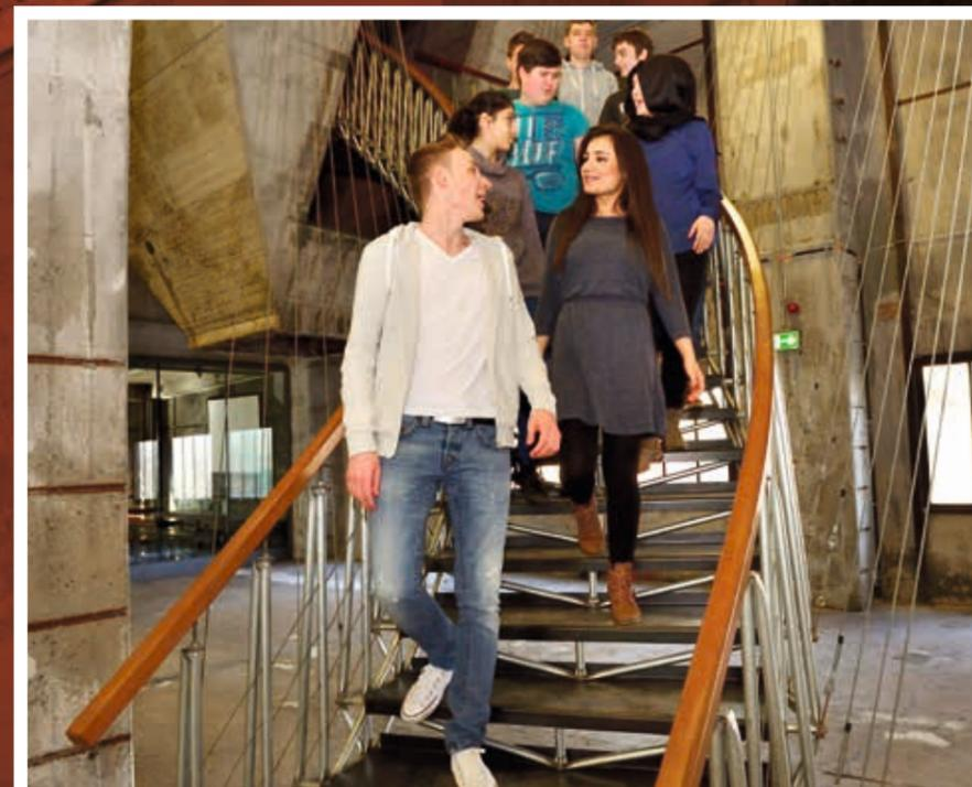
Von der Bunkerebene geht es über eine an Stahlseilen hängende Treppe zur Trichterebene.
