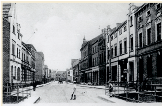
Ansicht vorder Erftbrücke auf die Bahnstraße um 1900. Im Haus Nr. 54 lebte die Familie Josef Moser, die eine Metzgerei betrieb. Ganz rechts unten an der Kreuzung befand sich das Schuhgeschäft „C. Jakoby“ des Ehepaars Eichengrün © Herlitz
