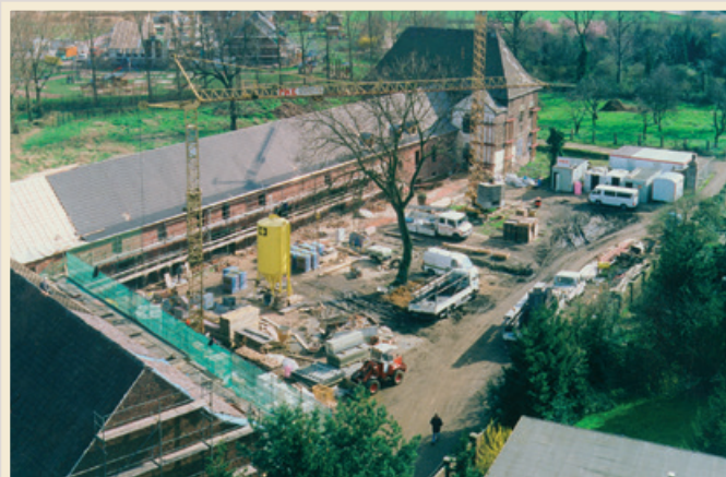
Die Baustelle des Deutschorderns-Kindergartens am Elsener Haus im März 1998.
