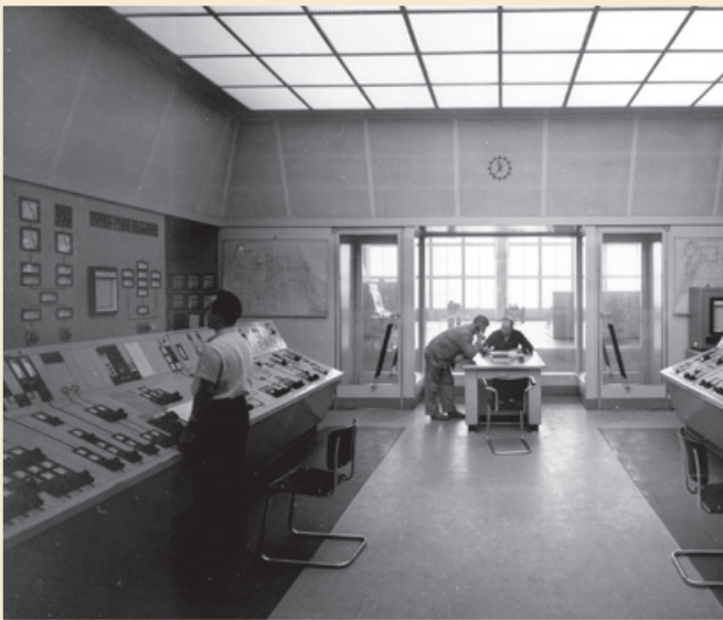
Im Leitstand des Kraftwerks in Frimmersdorf © Familie Hildebrandt
