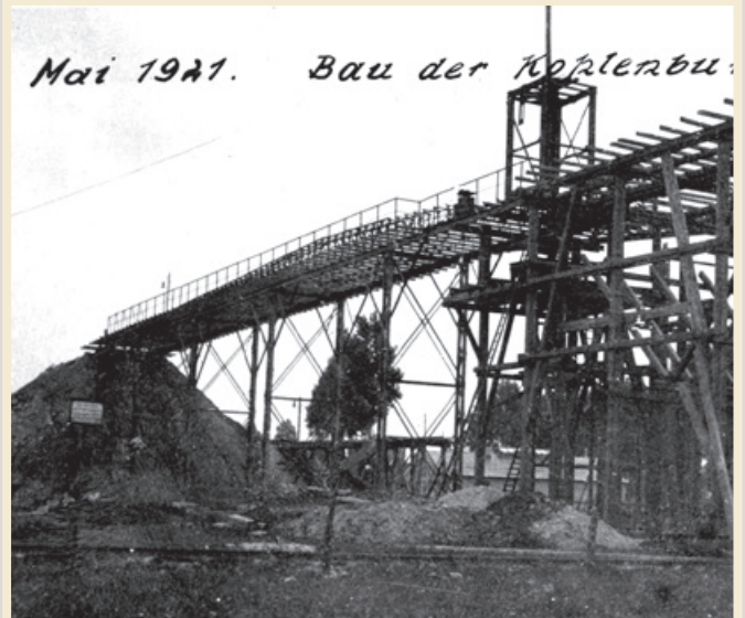
Bau der Kohlebunker 1921 © Familie Hildebrandt
