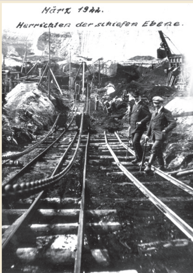
Gleisverlegung für die Kohle-Loren 1922. An massiven Ketten wurden die Loren gezogen © Familie Hildebrandt
