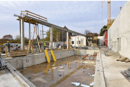
Es geht weiter auf der Baustelle - das neue Schlossbad soll im Herbst 2018 fertiggestellt werden.
