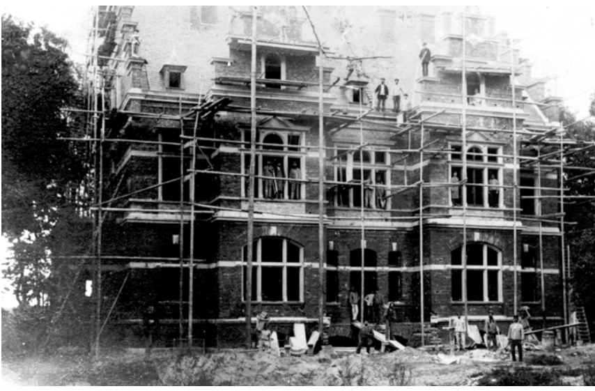
Diese wunderbare Aufnahme zeigt das Ständehaus an der Lindenstraße während der Bauphase um ca. 1885.
