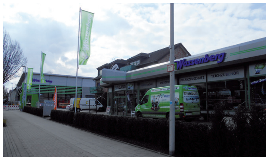
Firma Wassenberg an der Von-Goldammer-Straße
