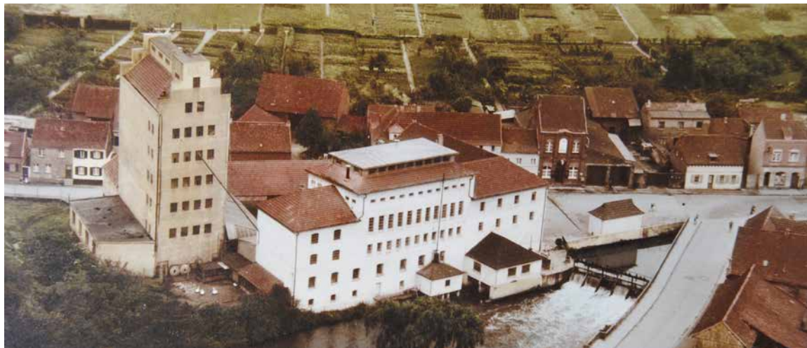
Luftaufnahme der Untermühle nach der Brandsanierung © Familie Drees
