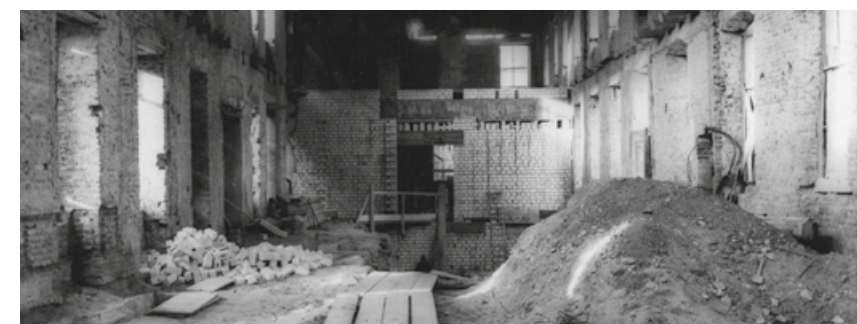
Entkernter Ostflügel während der Sanierung in den 1960er Jahren © Rita Krawinkel
