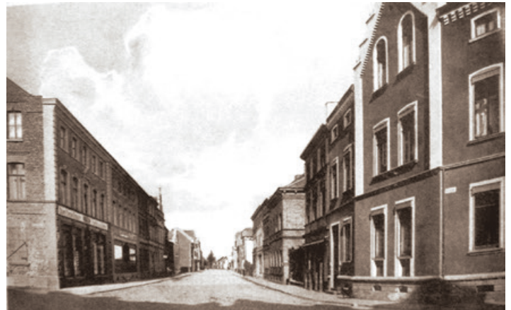
Ansicht Bahnstraße in Richtung Bahnhof. An der Kreuzung (links) befand sich das Schuhgeschäft „C. Jacoby“ des Ehepaars Eichengrün im Haus Nr. 6
