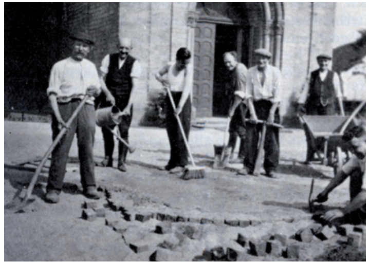
Pflasterarbeiten an der Elsener Kirche © Stadtarchiv Grevenbroich
