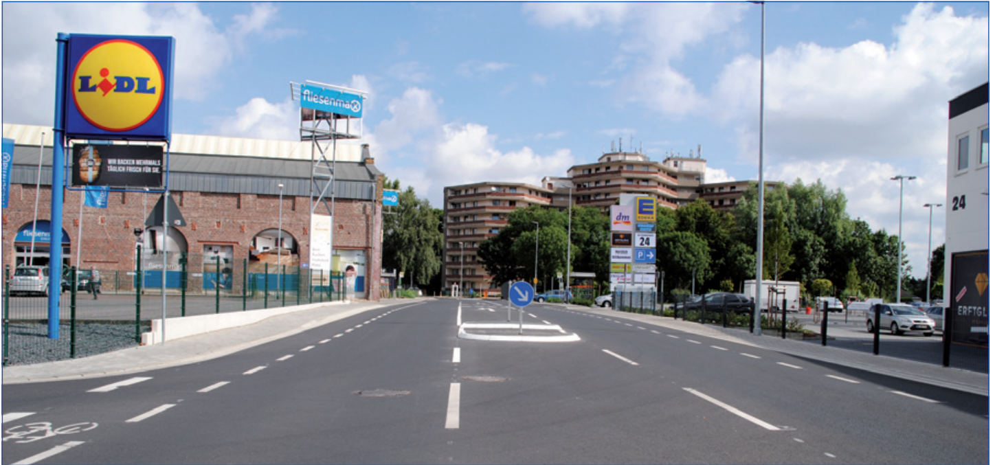
Optimierter Verkehrsfluss und -sicherheit: der neue Straßenzug am Hammerwerk
