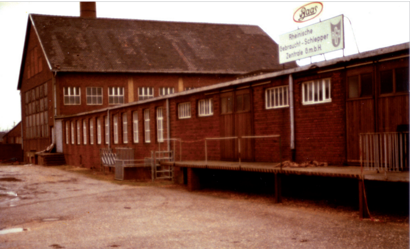
Rheinische Gebraucht-Schlepper Zentrale GmbH - Schrotthandel am Hammerwerk etwa Ende der 1970er Jahre © Dr. Stephan Hermanns
