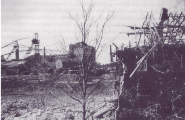
Bombenschäden an der Zeche Niederberg, 1945
