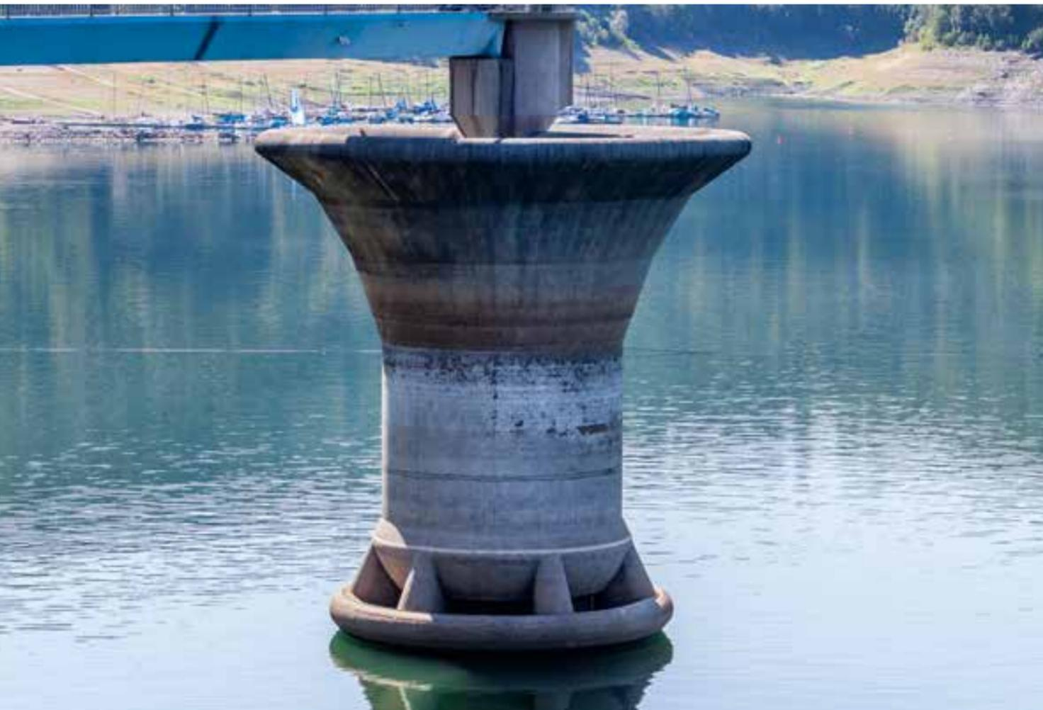
Um 15 Meter wurde der Stauspiegel der Biggetalsperre für die Sanierungsarbeiten am Hauptdamm abgesenkt. Der niedrige Wasserstand ließ sich auch an der Hochwasserentlastung erkennen.
