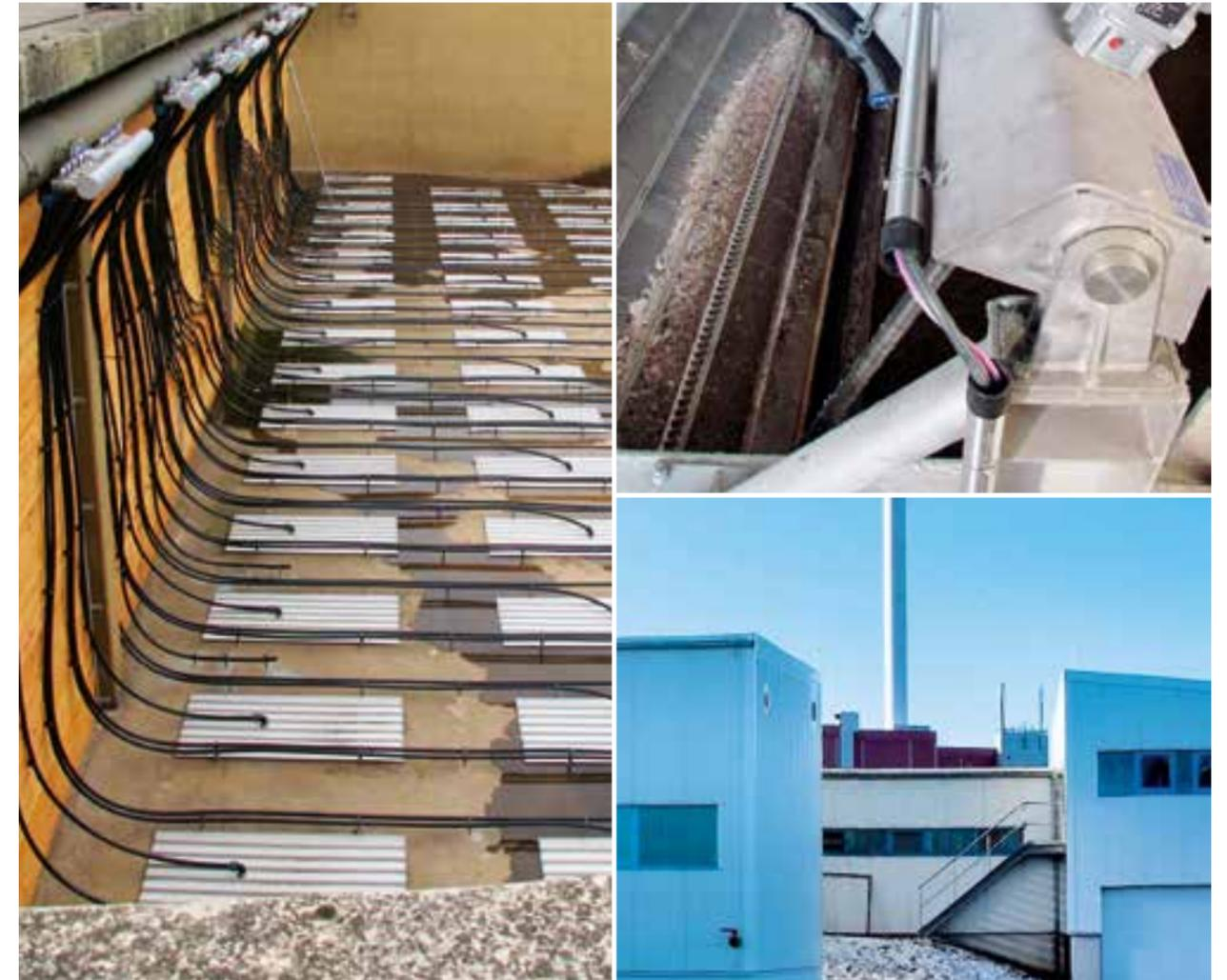
Die Kläranlage Ibbenbüren-Püßelbüren erhielt eine neue Belüftung (links), die Kläranlage Paderborn eine neue Feinrechenanlage (rechts oben). Unten: Die neue PFT-Anlage der ZEA Iserlohn von außen.
