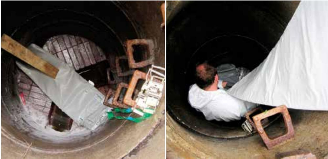
Bei einer durch die RWG vorgenommenen Kanalsanierung in Schmallenberg wurde das Inlinerverfahren angewandt. Der Vorteil dieses Verfahrens liegt in der grabenlosen Ausführung.
