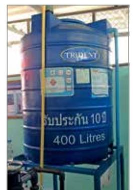
Mit einem Reosmosefiltersystem und individuellen Filtern produziert die wartungsarme Anlage je nach eingebautem Pump- bzw. Drucksystem bis zu 400 Liter Wasser pro Tag in Trinkwasserqualität.
