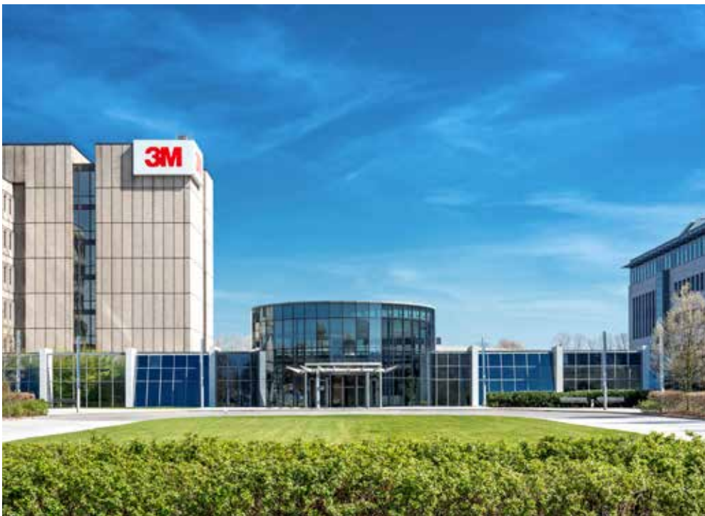
Das Gebäude von 3M in Neuss. Foto: Jochen Rolfes
